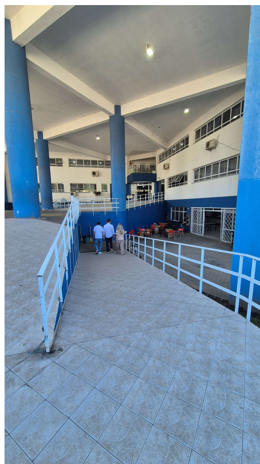
Figura 3 - Rampa de acesso interno à escola, para vencer os desníveis existentes
